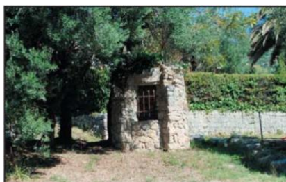
Puits sur les coteaux Nord
