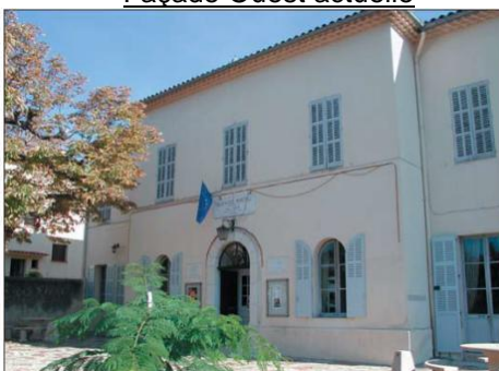
Façade Ouest actuelle
